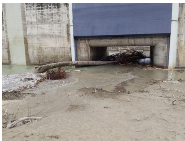
Figura. 165. Ostruzione di paratoie per il deposito di materiale legnoso.
