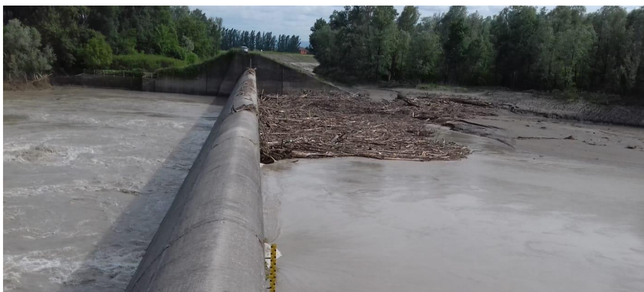
Figura. 162. Cassa di espansione sul F. Secchia: accumulo e completa ostruzione luci n°1+2 (da sponda destra) [14.05.2019].
