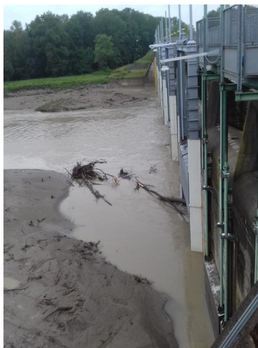
Figura. 166. Ostruzione di paratoie per il deposito di materiale legnoso.
