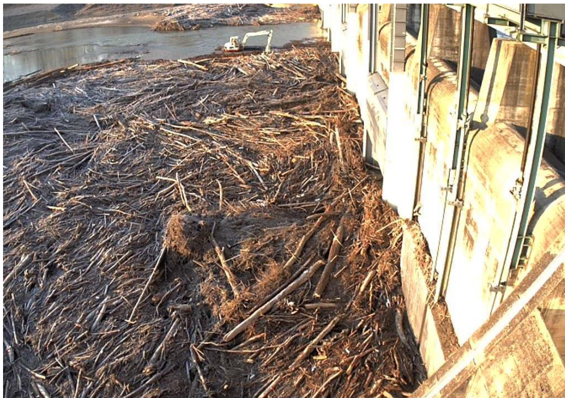
Figura. 164. Deposito di materiale legnoso e ostruzione luci del manufatto regolatore.
