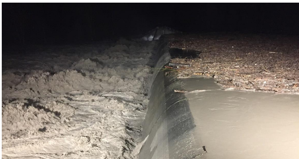
Figura. 158. Cassa di espansione sul F. Secchia: inizio sfioro su manufatto regolatore [12.12.2017].
